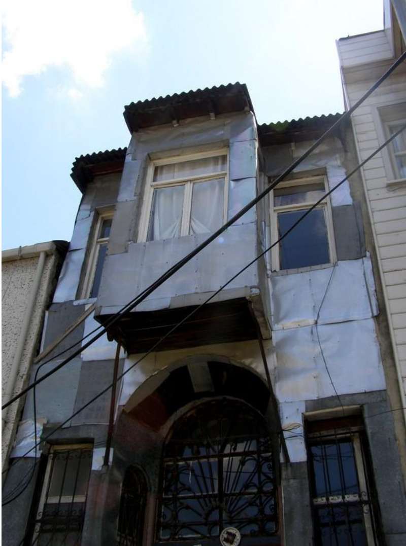
Fig. 3.2.xxviii Top Kapı area
