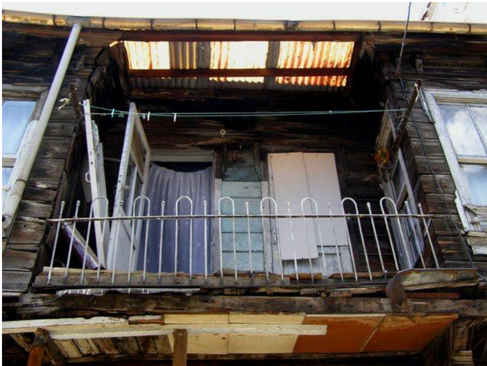
Fig. 3.2.92 Paşa Hamamı6; detail
